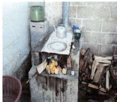
Foto14: 20.2 Sustrucción de estufa rural incluye chimenea
