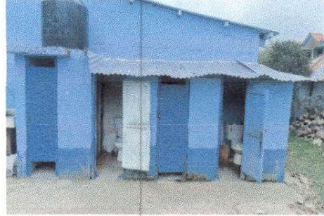
Foto 2: 4.3 Sustitución de Puerta
