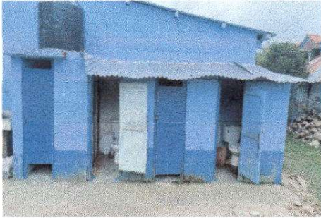
Foto1: 2.2 Sustitución de Estructura de Madera por Metal
