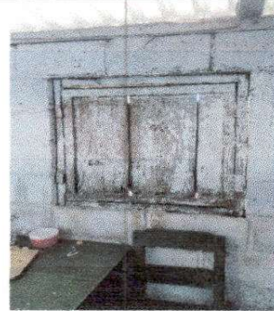
Foto 4: 5.3 Sustitución de ventana
