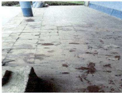
Foto7: 6.7 Sustitución de piso de granito
