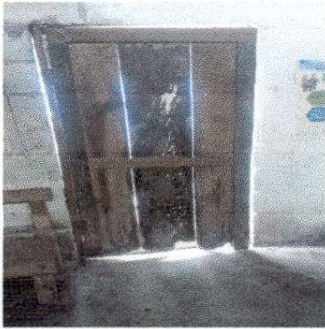
Foto 3:4.3 Sustitución de Puerta
