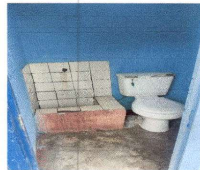
Foto 10: 10.3 Sustitución de inodoro
