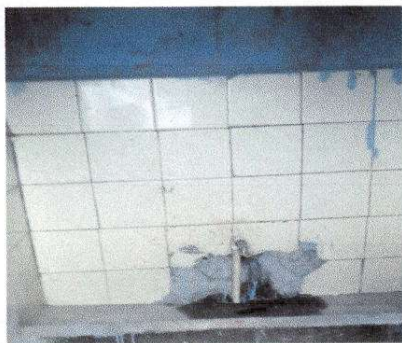
Foto 13: 13.1 Sustrucción de azulejo
