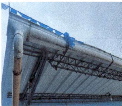
Foto 9 :7.4 Sustitución de bajada de agua pluvial de metal por tubo PVC 3"
