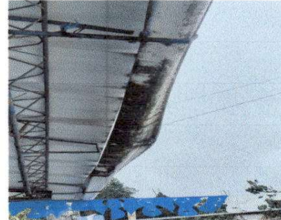
Foto 8: 7.2 Sustitución de canal de PVC
